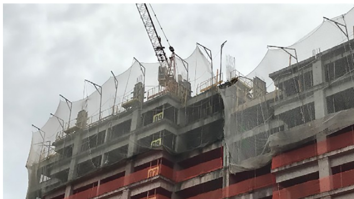
Figura 3: Sistema limitador de quedas em altura
