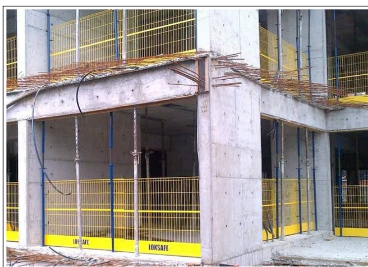
Figura 24: Sistema de guarda corpo
