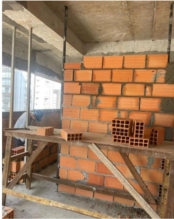
Figura 6 - Execução de elevação de alvenaria de vedação
