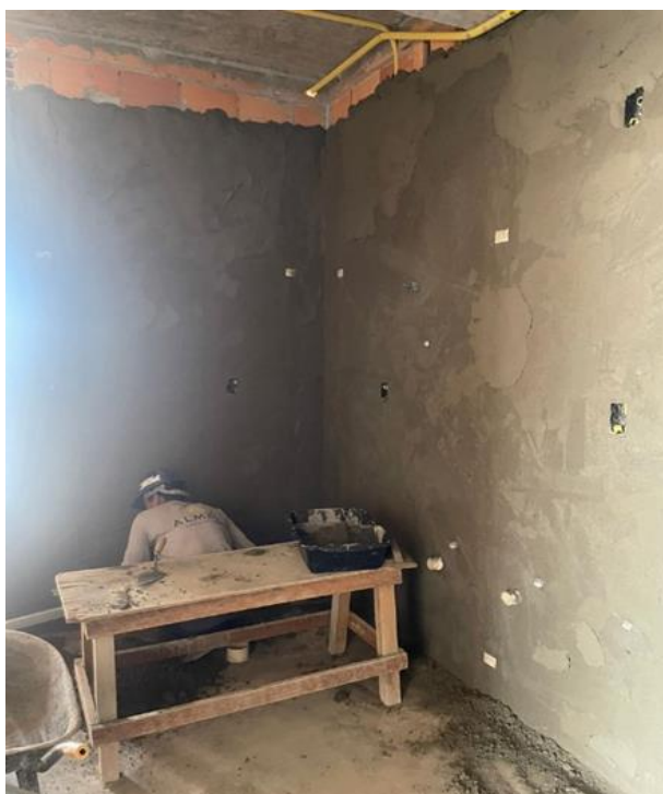
Figura 8 - Execução de Reboco Interno
