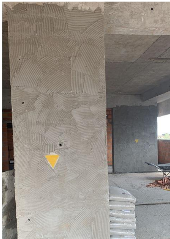
Figura 7 - Execução de Chapisco
