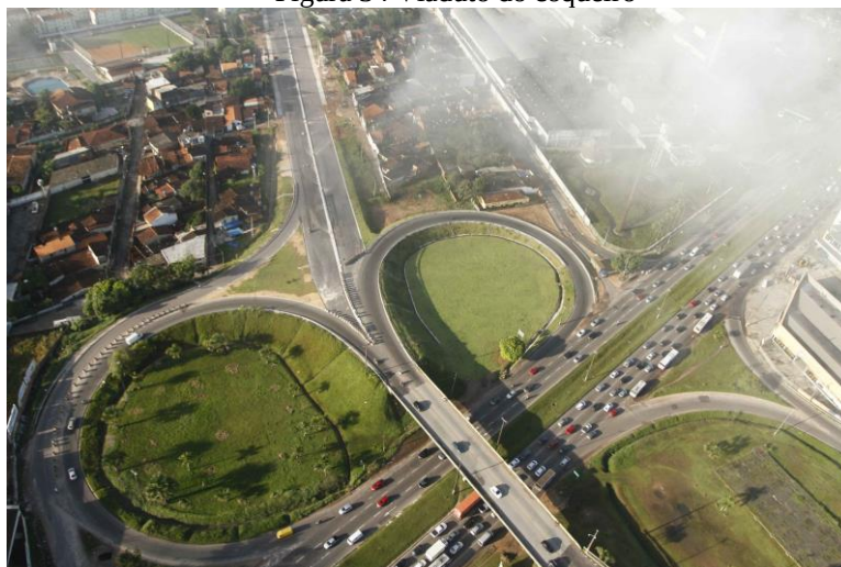
Figura 34 Viaduto do coqueiro
