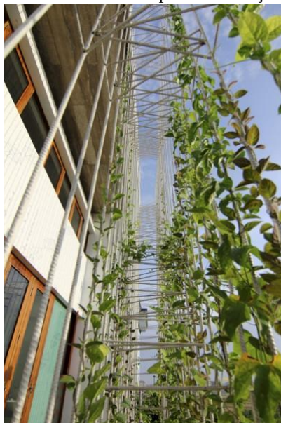
Figura 20 Módulos tridimensionais para sustentação de brise vegetal
