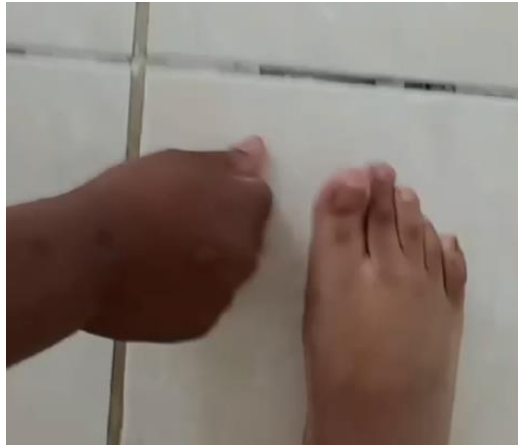
Figura 1. Teste de percussão e movimento de peça solta (fragmento de vídeo).
