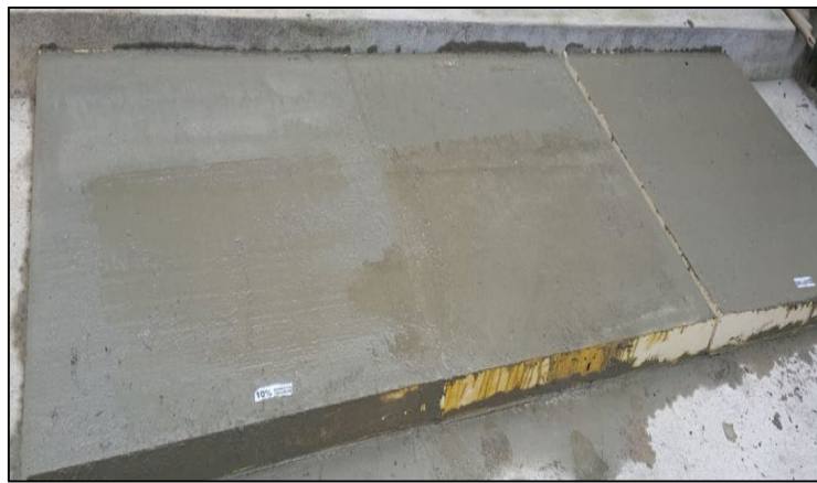
Figura 14 - Contrapisos de 10 %, 20 % e 30 % com borracha e 100mm de espessura.
