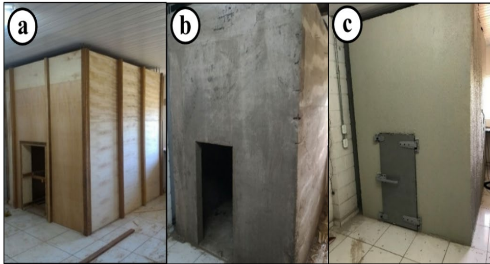
Figura 10 - Etapas de construção da minicâmara: (a) formas de madeira para preenchimento com concreto, (b) câmara após a cura do concreto e (c) após a instalação da porta e ferragens.
