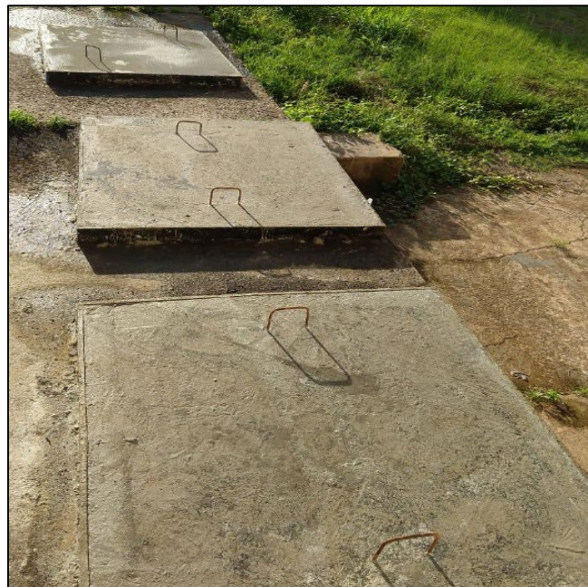
Figura 15 - Contrapisos de 10 %, 20 % e 30 % com borracha e 60mm de espessura.
