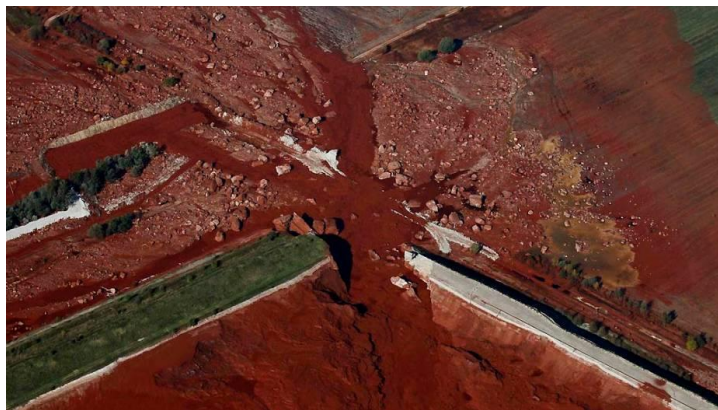
Figura 7 - Área do reservatório de resíduos de alumínio - Hungria
