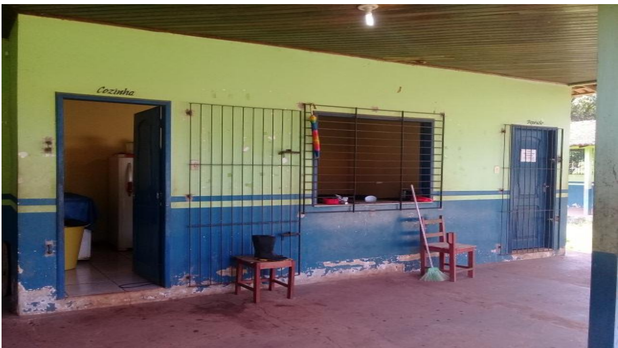
Figura 4 - Cozinha da escola Eduardo Angelim II
