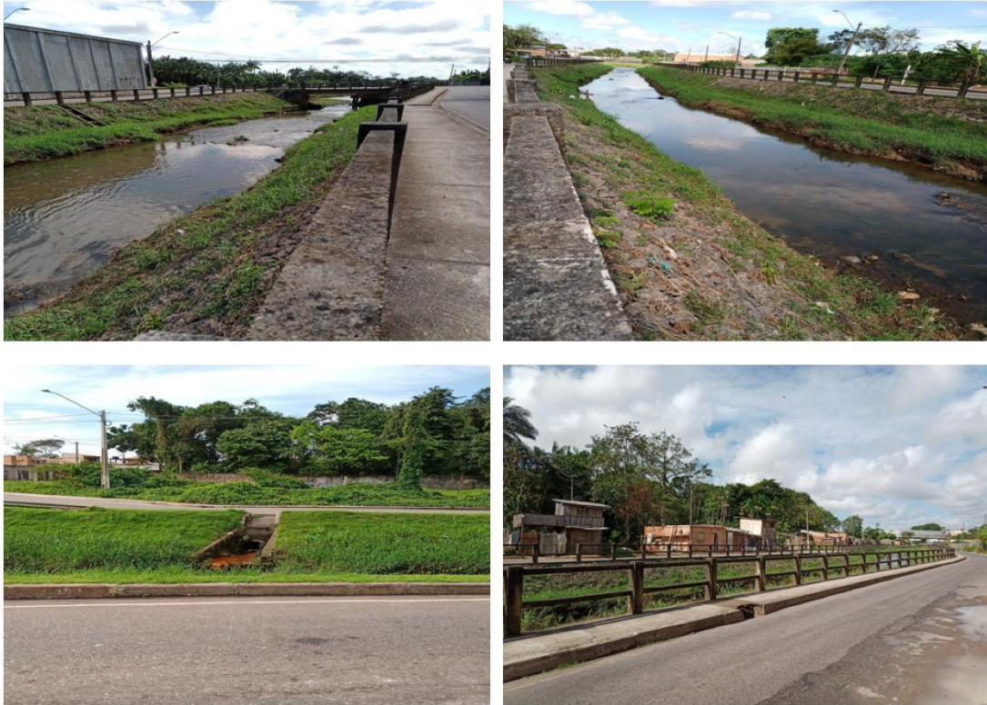
Figura 4: Imagens do trecho canalizado do Rio Maguari-Açu.
