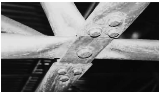
Figura 2. 26 - Nó típico com chapa complementar. Fonte: Souza, Alex (1998).
