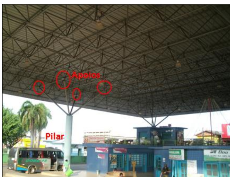
Figura 3.2 - Pilar e apoios tipo “pé de galinha”.
