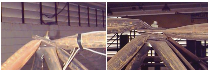
Figura 2. 25 - Colapso em nó típico. Fonte: Maiola (1999).
