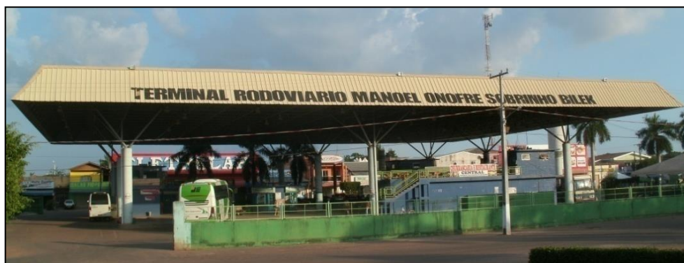
Figura 3.1 - Terminal rodoviário de Breu Branco/PA.
