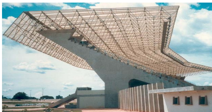
Figura 2.8 - Cobertura do antigo estádio Mané Garrincha. Fonte: Souza, Arnaldo (2002).
