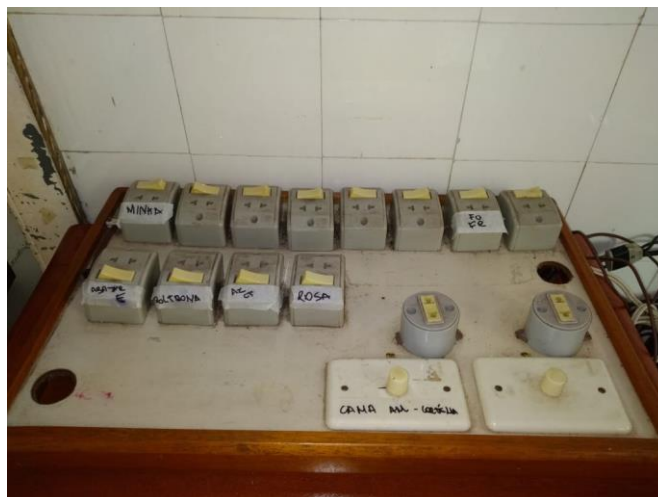
Figura 49: A mesa possui quatorze canais sendo dois dimerizáveis.
