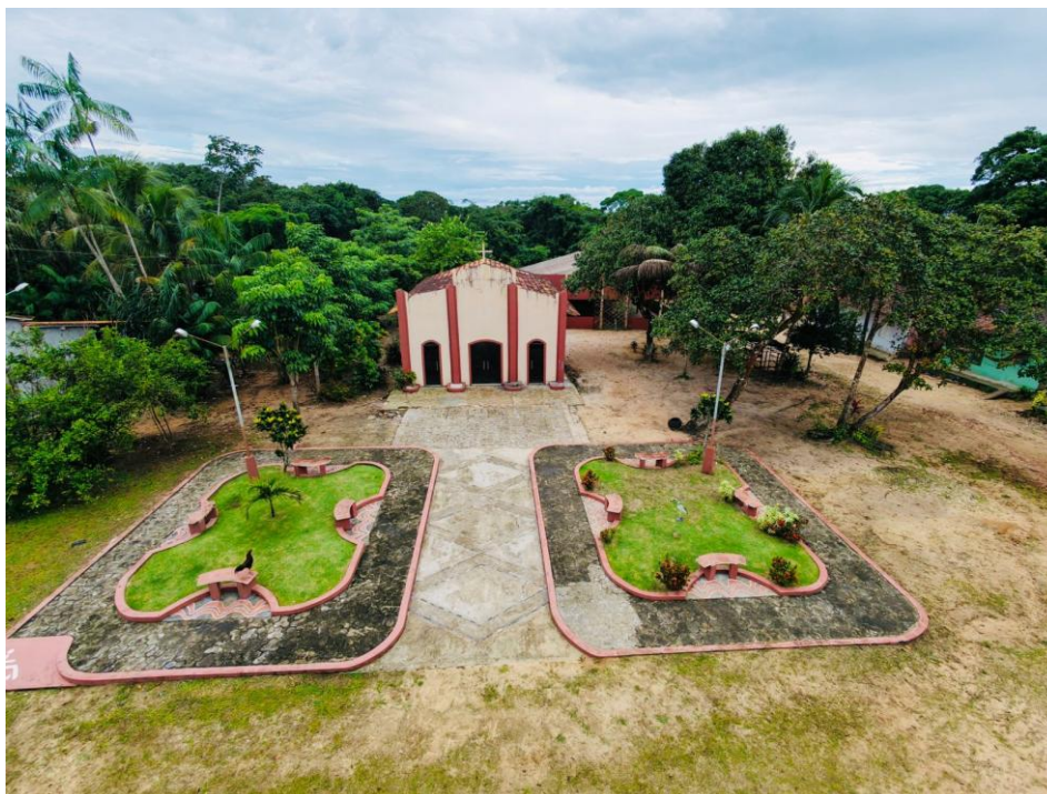
Imagem 3: Igreja de Nossa Senhora do Bom Parto na Comunidade da Mangueira.
