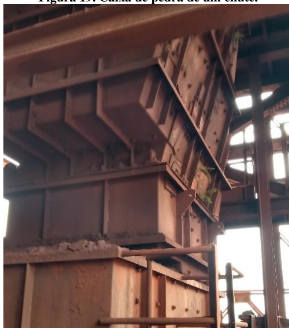
Figura 19. Caixa de pedra de um chute.
