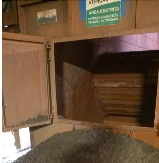
Figura 23. Porta de inspeção localizada no módulo superior.
