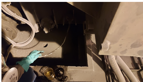
Figura 3.1 – Coleta de amostra de óleo do Transformador de Potência
