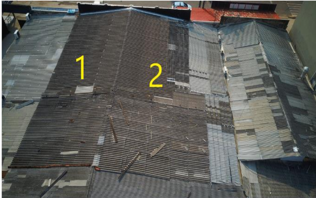
Figura 5.3 - Exposições para a instalação dos módulos
