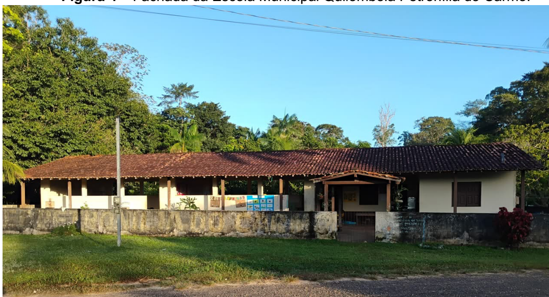
Figura 4 – Fachada da Escola Municipal Quilombola Petronília do Carmo.
