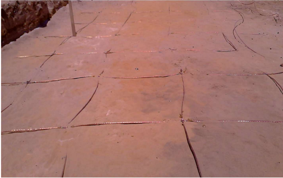
Figura 2 - Construção da subestação
