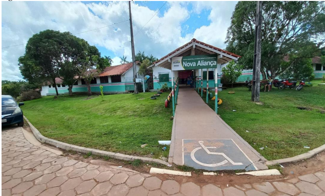
Figura 2: Prédio da escola Nova Aliança.
