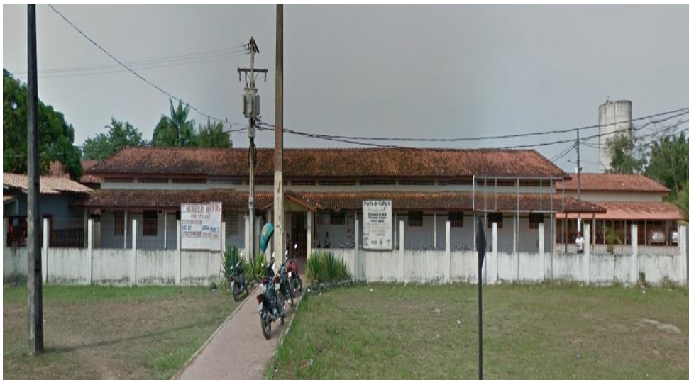
Figura 3: Vista frontal da escola
