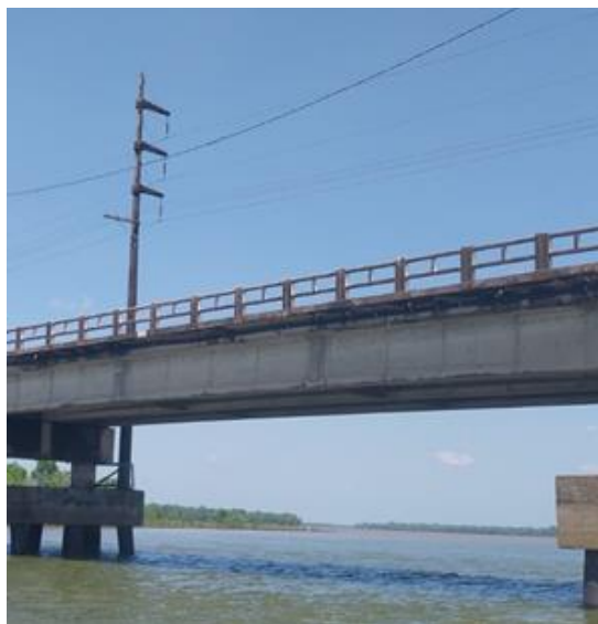
Foto 18. Ponte Sebastião Oliveira. Fonte: Autor (2024).
