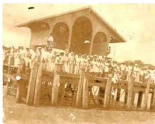
Foto 8. Trapiche de Mosqueiro em 1945. Fonte: Wanzeller, (2010).
