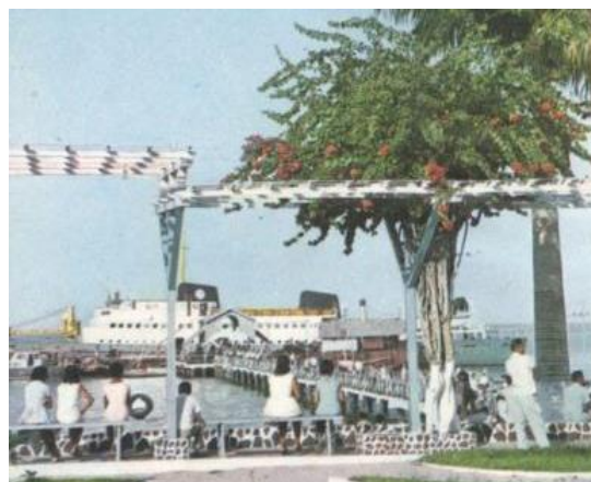
Foto 10. Trapiche de Mosqueiro em 1966. Fonte: Rodrigues, (1966, p. 50).
