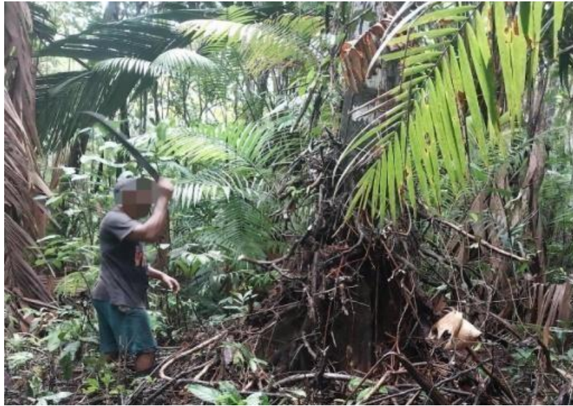
Figura 2: Limpeza do local
