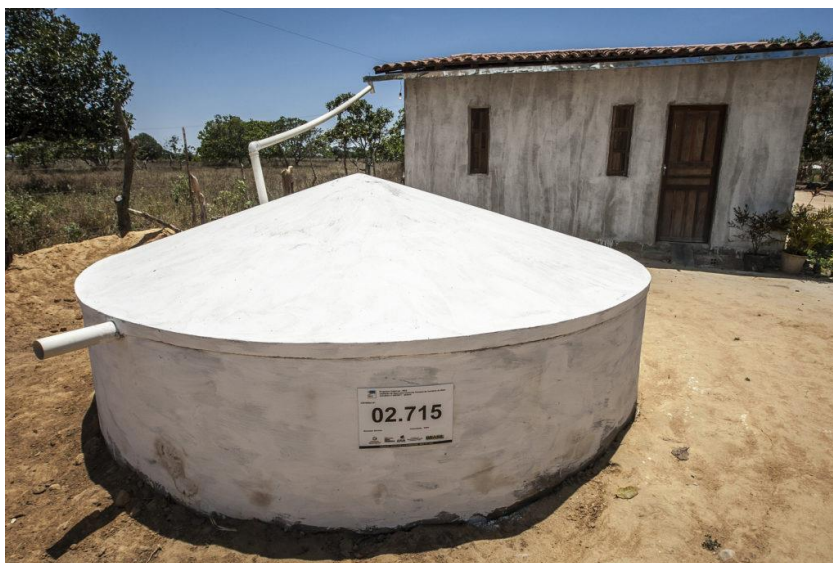
Figura 9 - Cisterna de concreto para captação de água da chuva.
