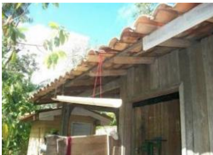
Figura 28 - Sistema de aproveitamento da água da chuva improvisado por moradores.
