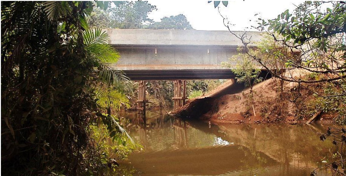
Figura 17 - Imagem da Ponte sobre o Rio Chatopauá.
