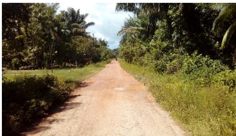
Figura 2- Estrada de acesso ao Assentamento
