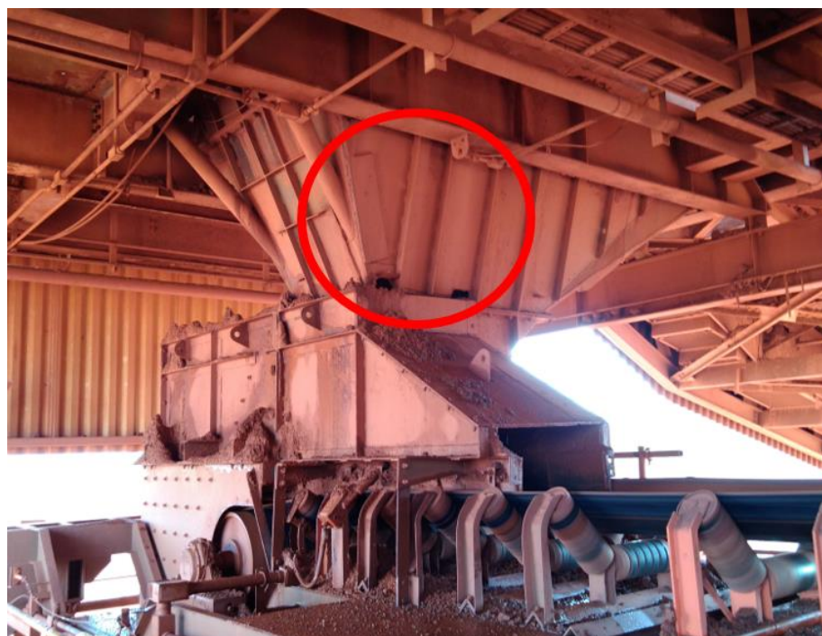
Figura 9. Manutenção Corretiva na parte frontal do chute de descarga da 621B-TP-0003
