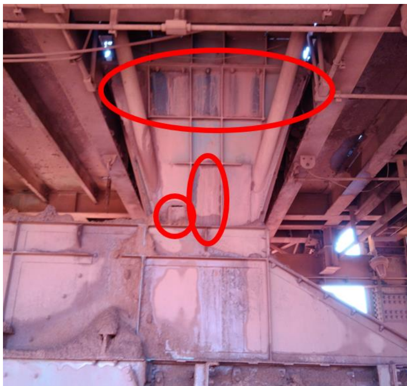
Figura 8. Manutenção Corretiva na lateral do chute de descarga da 621B-TP-0003.
