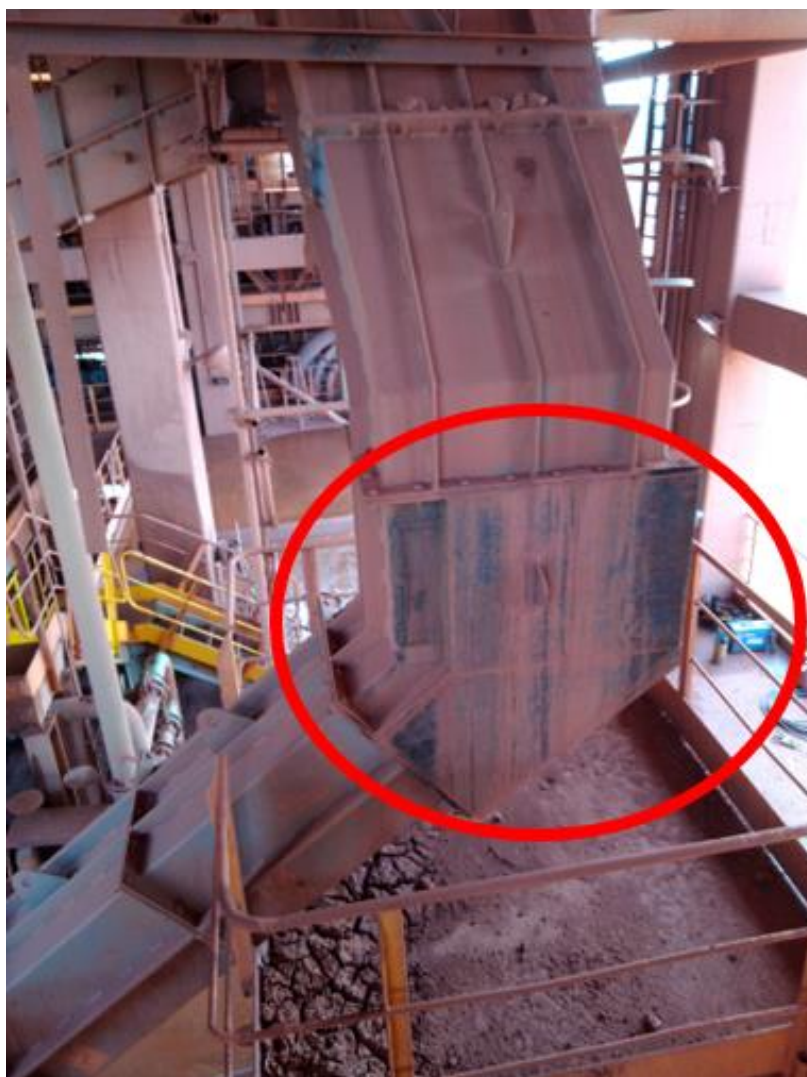
Figura 17. Solução Paliativa no chute de descarga de grossos do lavador 631B-LV-0001/2
