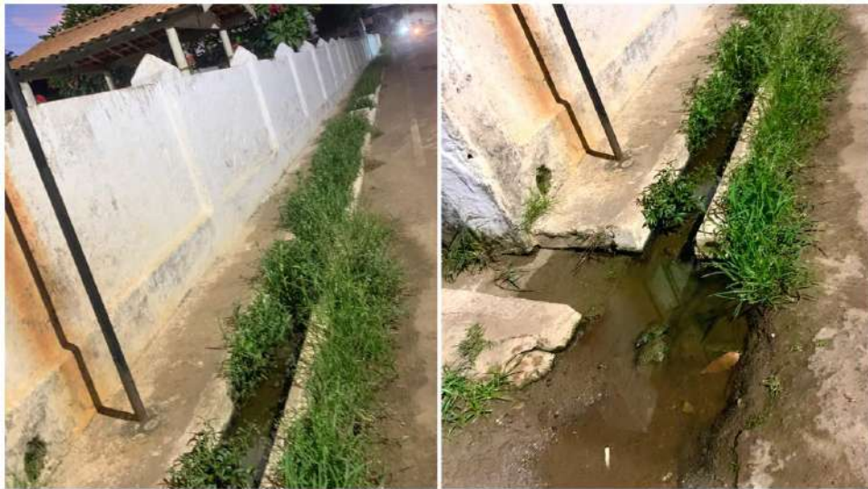
Figura 4.5 – Disposição das águas oriundas do cemitério
