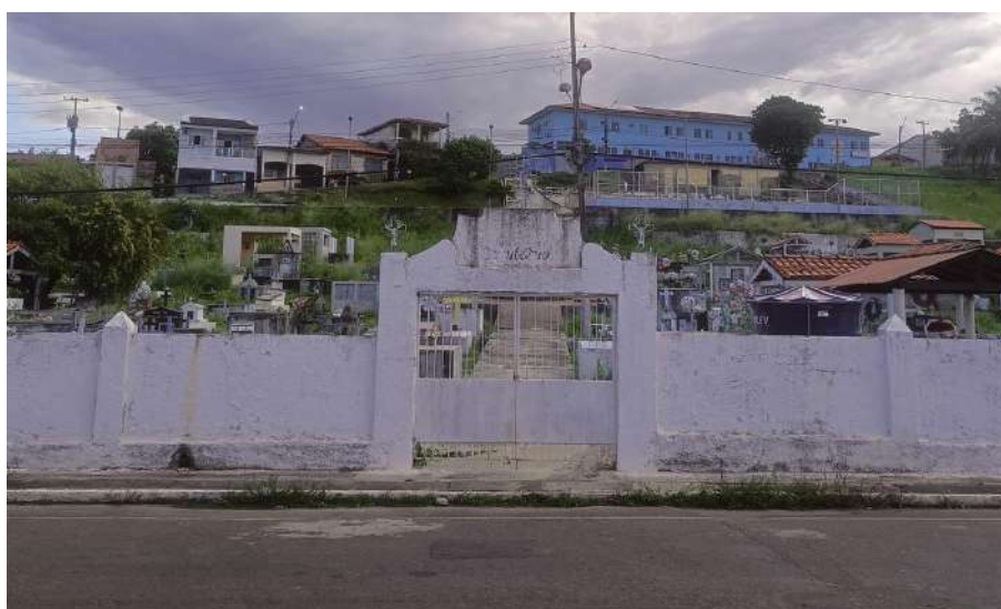
Figura 3.2 – Fachada do Cemitério Santa Isabel
