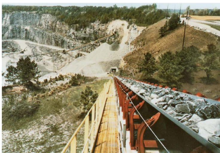
Figura 4 – Transporte de caulim no sistema transportador por correia
