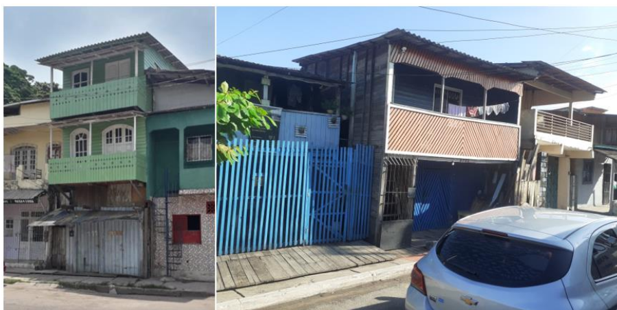
Figura 1: Exemplo de Construções em tipo Palafita na RMB.
