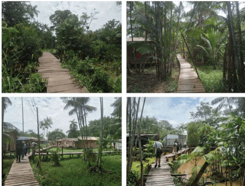
Figura 19 - Estivas de madeira conectam as edificações da Comunidade.
