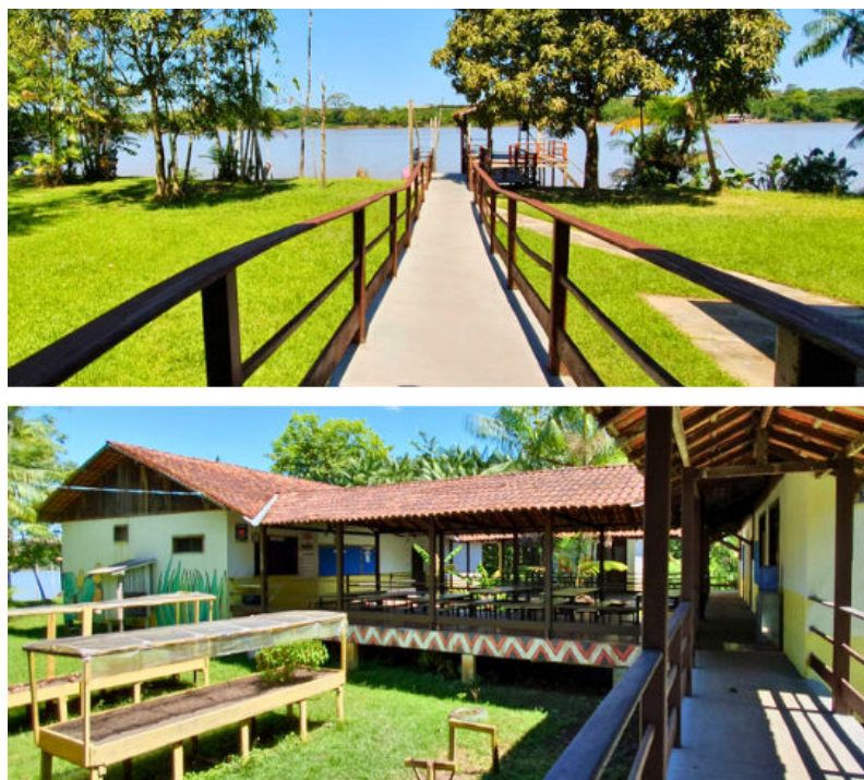
Figura 11 - Visibilidade do exterior da Escola Municipal Prof.º Milton Monte.
