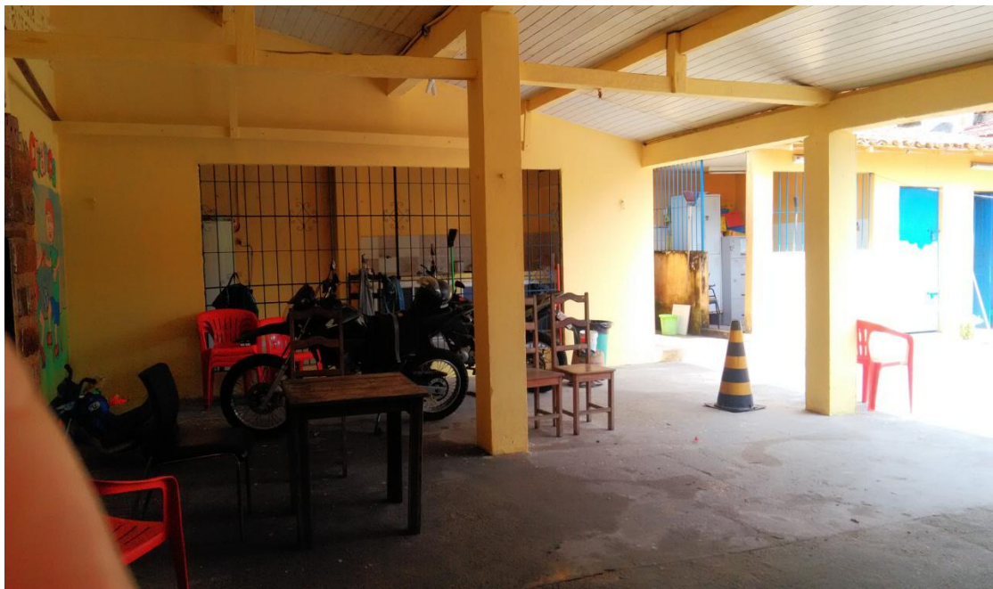
Figura 5: Na parte externa temos a lavanderia (aos fundos da foto), uma área com grade onde se tem armários com armazenamentos antigos (lado direito) e na lateral tem o alfabeto na parede com desenhos lúdicos.
