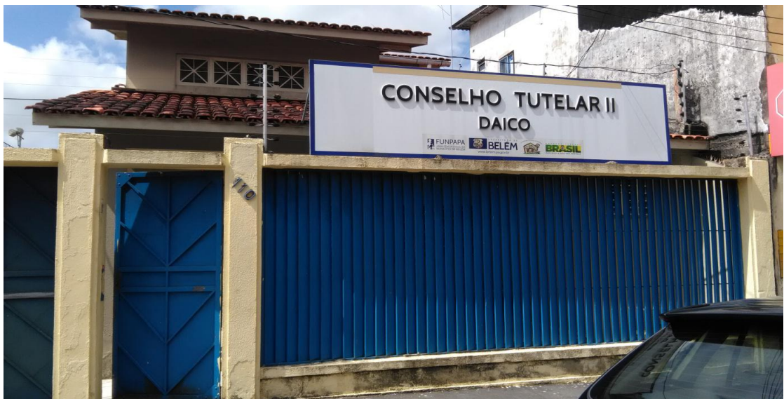
Figura 1: Fachada do Conselho Tutelar II no distrito de Icoaraci em Belém-PA Fonte: autora
