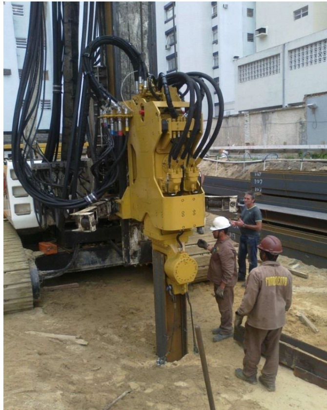
Figura 2 - Martelo vibratório acoplado à escavadeira
