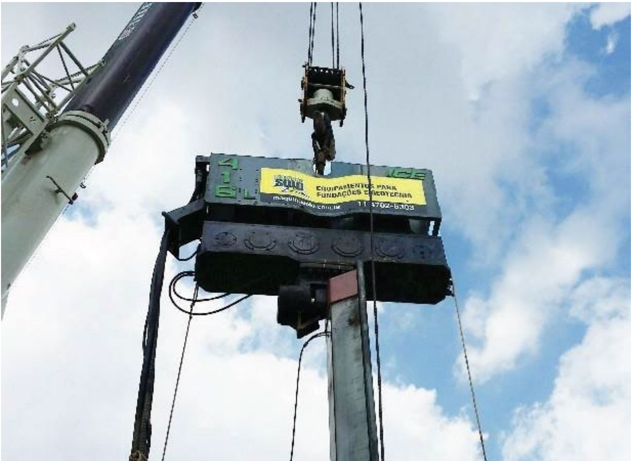
Figura 1 - Martelo vibratório suspenso por guindaste
