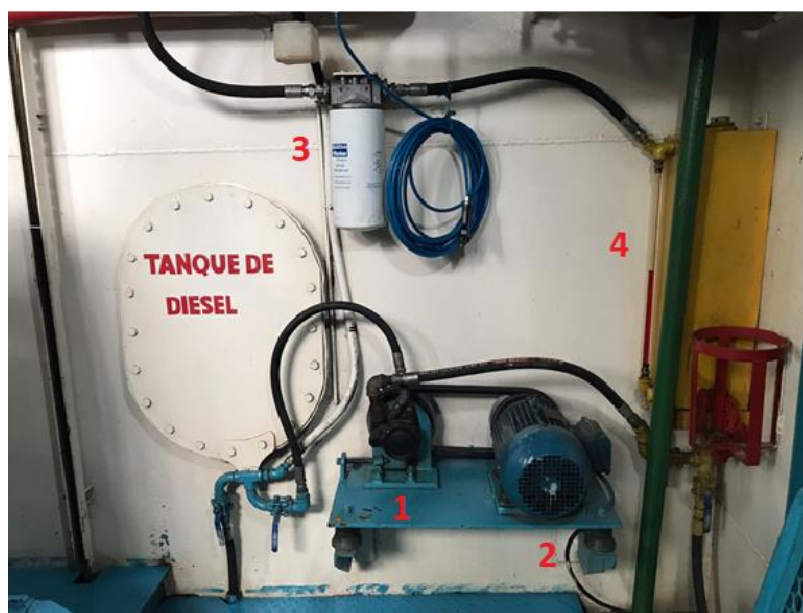
Figura 33. 1- Bomba Hidráulica; 2- Motor Elétrico; 3- Filtro; 4- Reservatório
