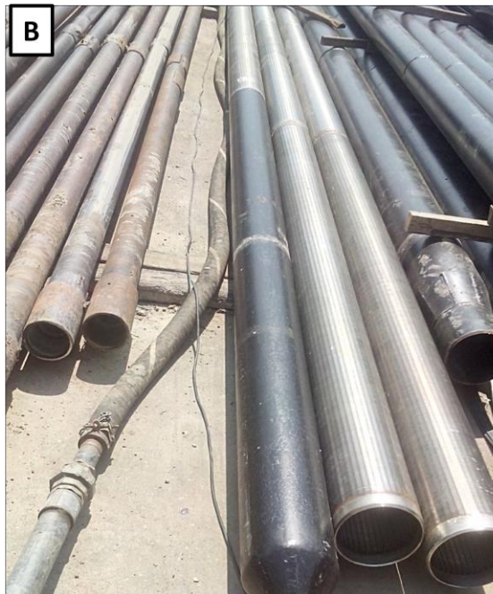
Figura 3: A) Fotografia que mostra a execução da perfilagem geofísica. B) Imagem que mostra no detalhe à esquerda os tubos de aço de carbono e à direita os filtros de aço inox. C) Fotografia que mostra a colocação do pré-filtro. D) Imagem em detalhe do tanque para medição de vazão.
