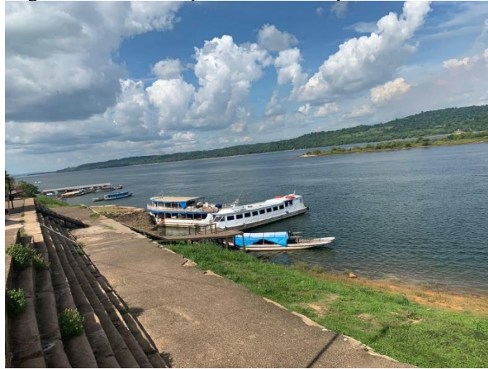
Figura 11 - Cais do porto no município de Tucuruí-Pa
