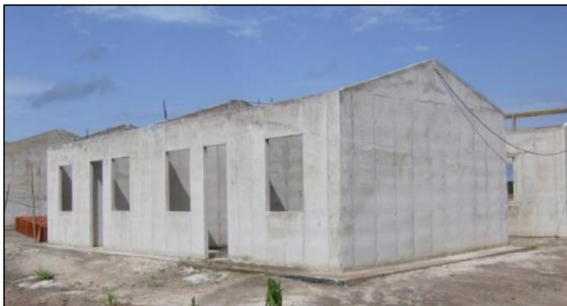
Figura 2.7 – Vedação e estrutura como único elemento.
