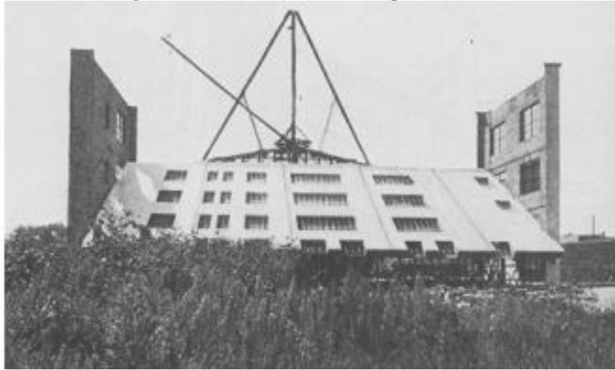
Figura 3 – Fábrica construída com pré-moldados
