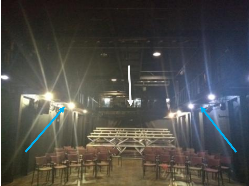
Figura 26: Passarelas fixas a mostra nos canto superior esquerdo e direito. Acima do mezanino a passarela central.
