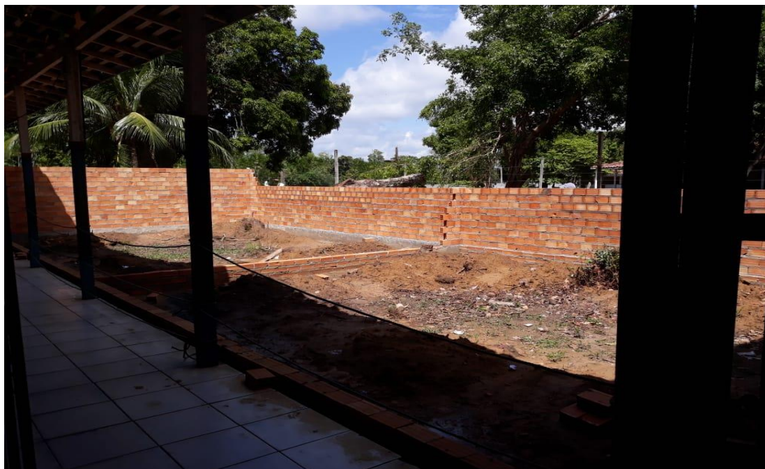
Figura 9: Estrutura da construção das salas do ensino fundamental maior.
