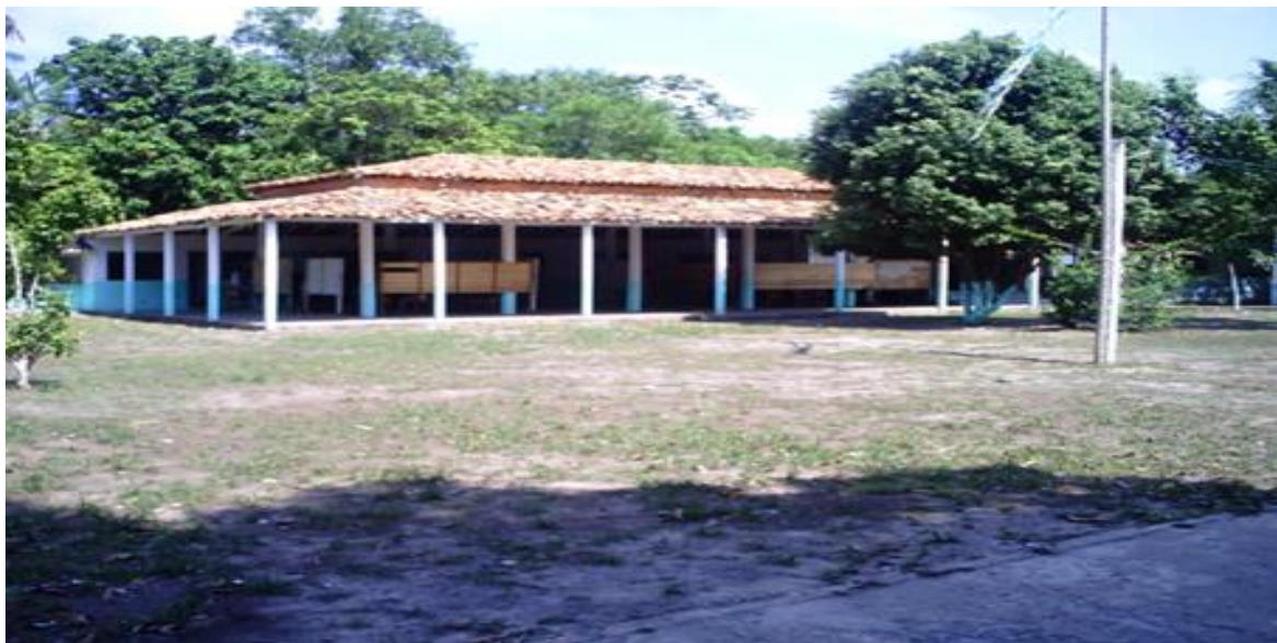
Figura 6 - barracão onde funciona o ensino fundamental maior.
