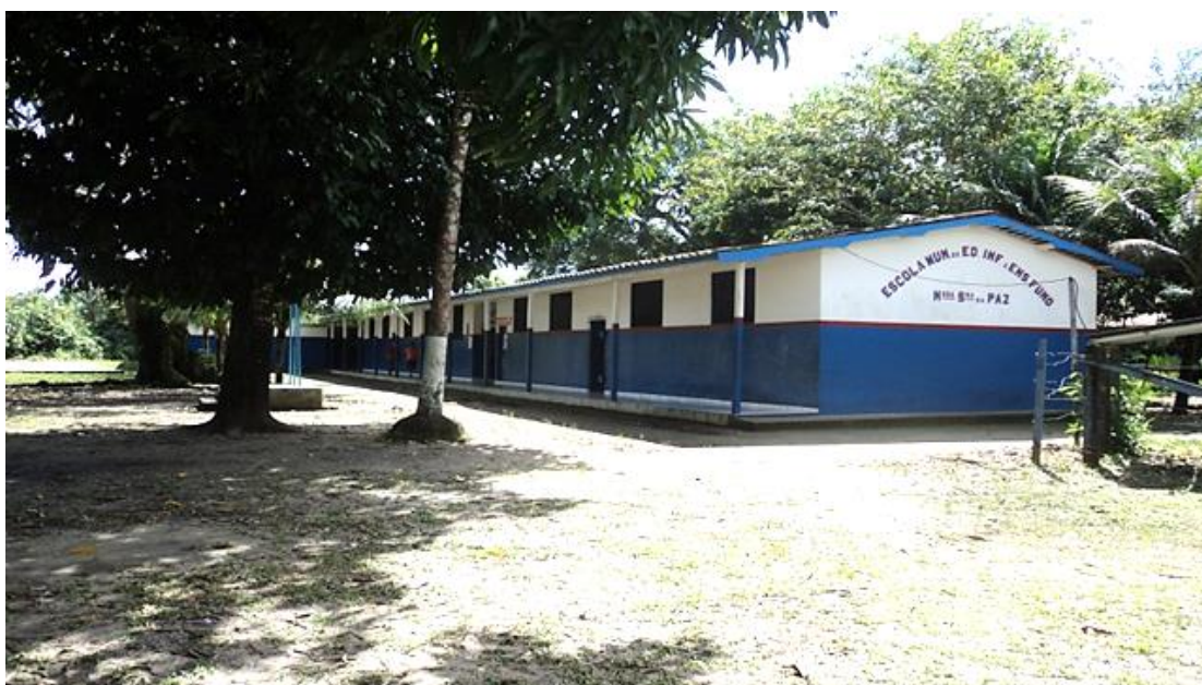
Figura 5 - Prédio do ensino fundamental menor.
