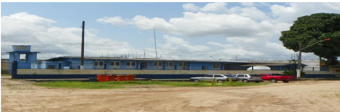
Figura 01 -Vista frontal do Centro de Recuperação do Coqueiro - CRC
