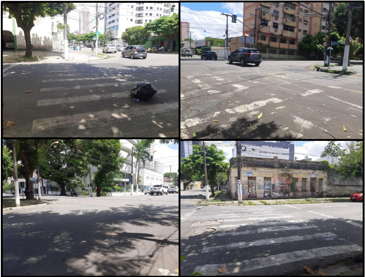
Figura 33 – Trechos com a falta de sinalização adequada (FTP)
