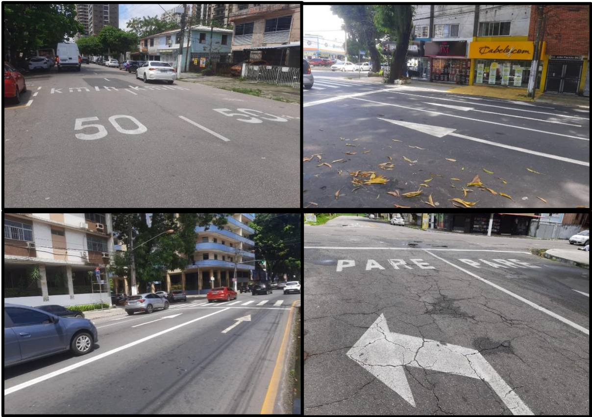
Figura 34 – Inscrições nos pavimentos com visibilidade adequada
