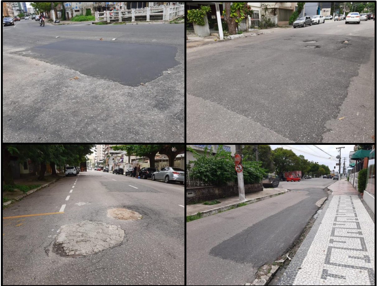
Figura 27 – Exemplo de remendos
