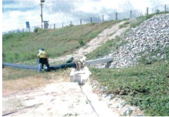
Figura 17 - A figura mostra o Filtro invertido no talude da bacia de rejeitos n.º 5 C, onde há reforço de pedras. Fonte: (CPC 2014 apud Lemos 2021).
