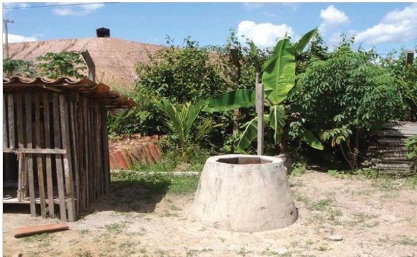
Figura 11 - A Figura mostra o Poço do Tipo Amazonas, para captação de água em residência no bairro Industrial, localizado ao lado da bacia de rejeitos n.º 3 da Imerys. Fonte: (Lemos 2018 apud Lemos 2021).
