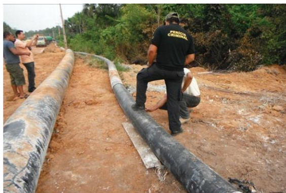
Figura 14 - A figura mostra parte do mineroduto substituído após incêndio na vegetação. Fonte: ( Lemos 2018). Aadaptado pela autora.
