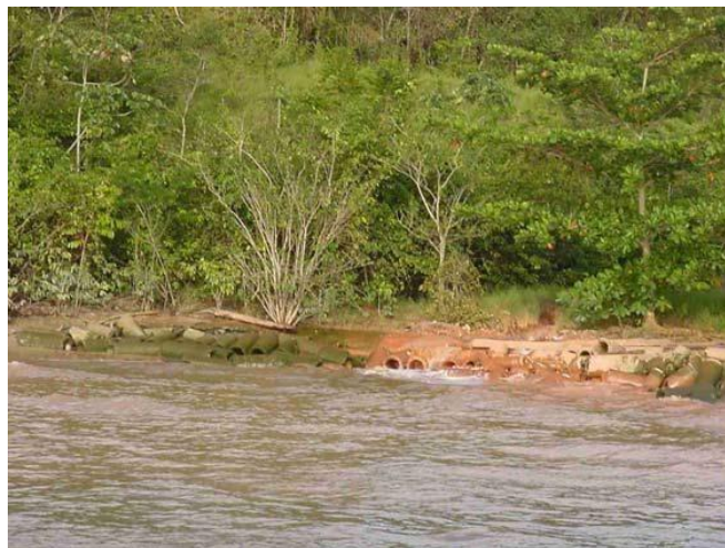
Figura 9 - Esgoto de origem industrial despejado na baía do Marajó próximo a praia de Itupanema no município de Barcarena-Pa. Fonte: (IEC 2003b).
