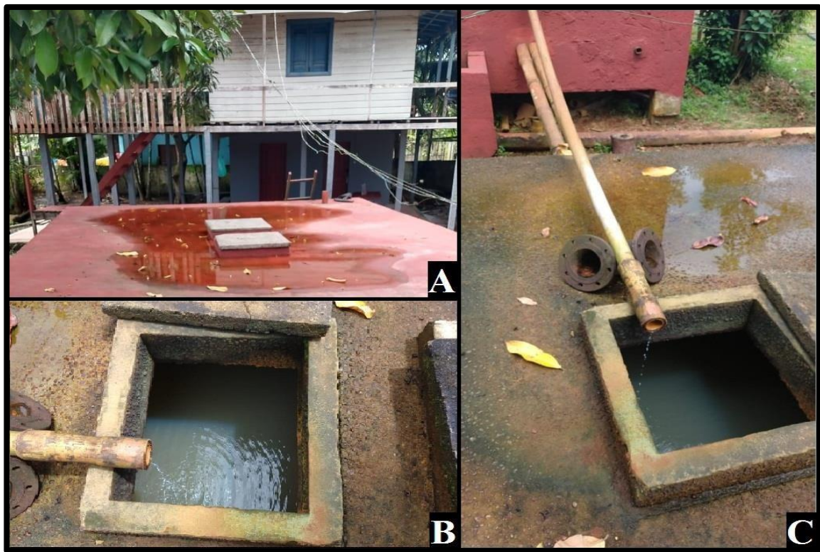
Figura 6 - A : Cisterna; B : Interior da cisterna abastecida; C : Encanamento vindo do filtro para abastecimento da cisterna.
