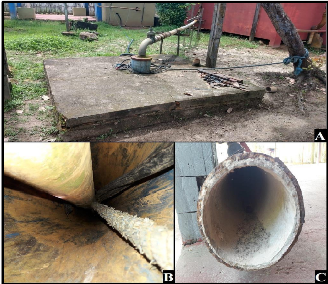
Figura 3 - A: Poço; B: Interior do anel do poço; C: Tubulação.
