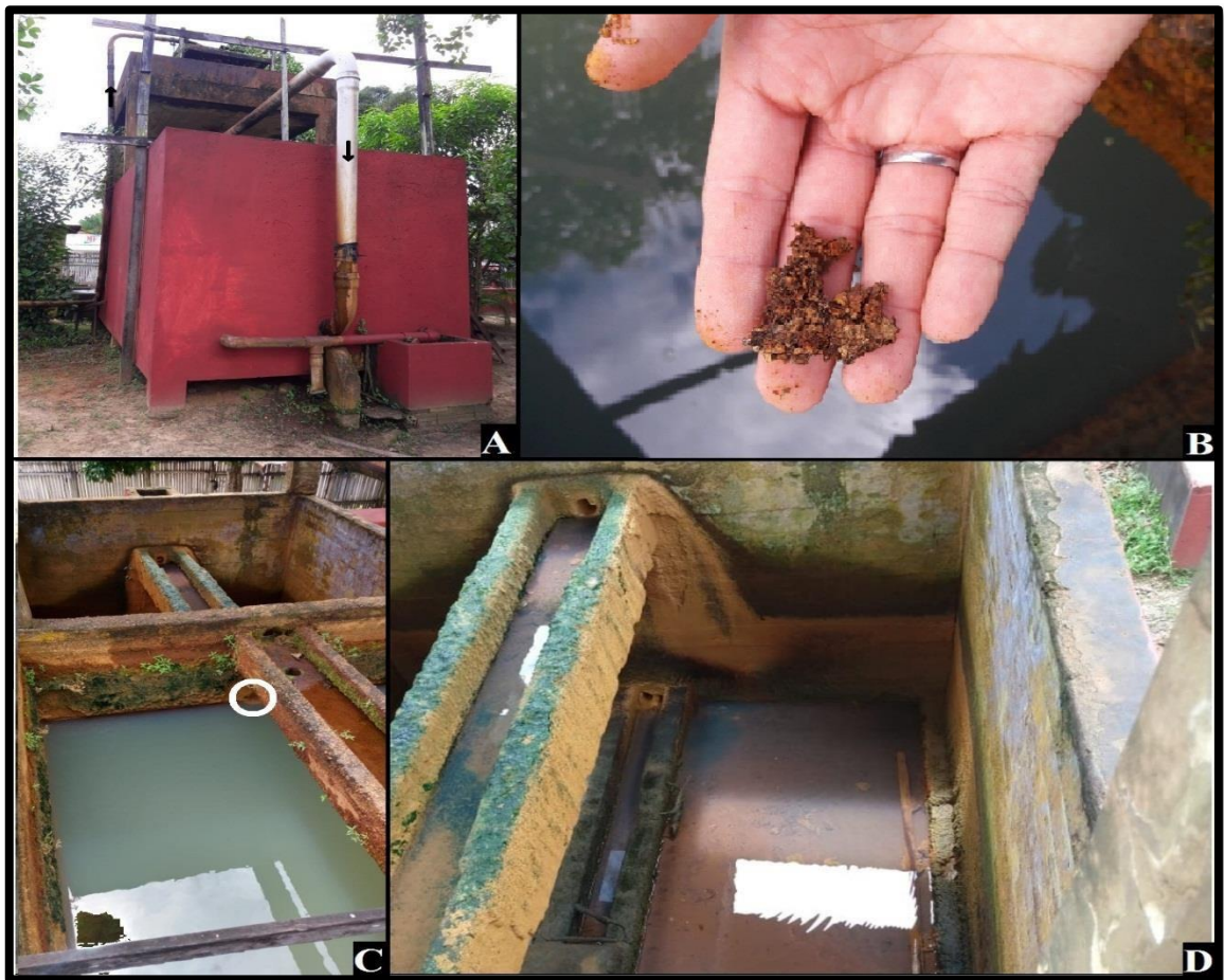
Figura 5 - A: Aerador e filtro (setas mostrando a trajetória da água); B: Sedimento da parede do filtro; C: Compartimento 1 (círculo mostrando “atalho”) e 2 do filtro; D: Compartimento 2 do filtro.
