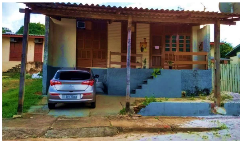
Figura 36 - Vista frontal da Residência IV
