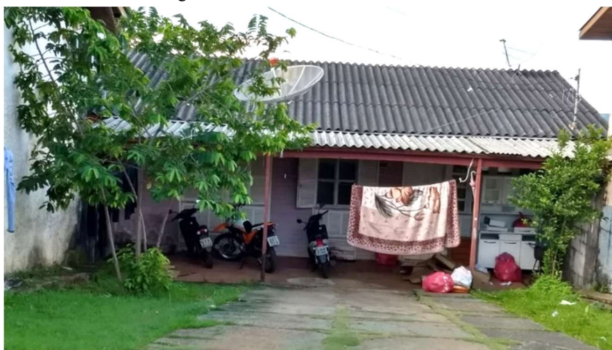
Figura 24 - Vista frontal da Residência I
