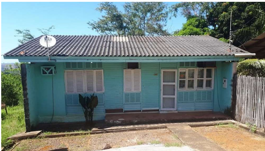
Figura 11 - Visão Externa de uma Residência da Vila Tropical
