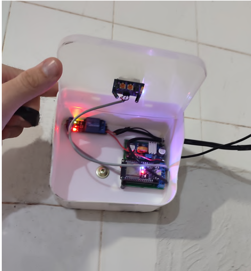
Figura 4.11 – Protótipo instalado - aberto.
