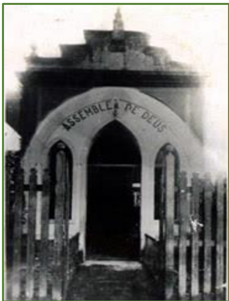
Figura 19 - Fachada do primeiro templo da Assembleia de Deus em Belém, Pará, 1914.
