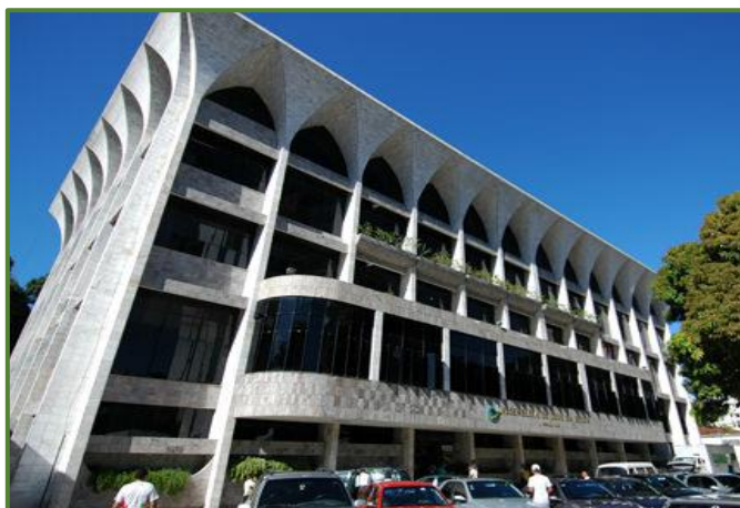
Figura 21 - Fachada atualmente do templo central da Assembleia de Deus, Belém, Pa.
