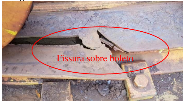
Figura 19. Fissuras sobre boleto do trilho.
