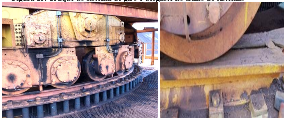
Figura 15. Truque do sistema de giro e desgaste no trilho do sistema.
