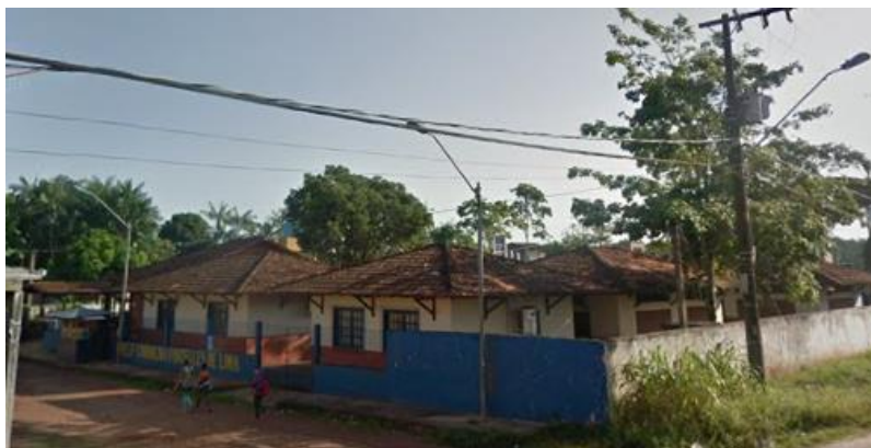
Figura 2 -Foto da Escola Cordolina Fontelles.
