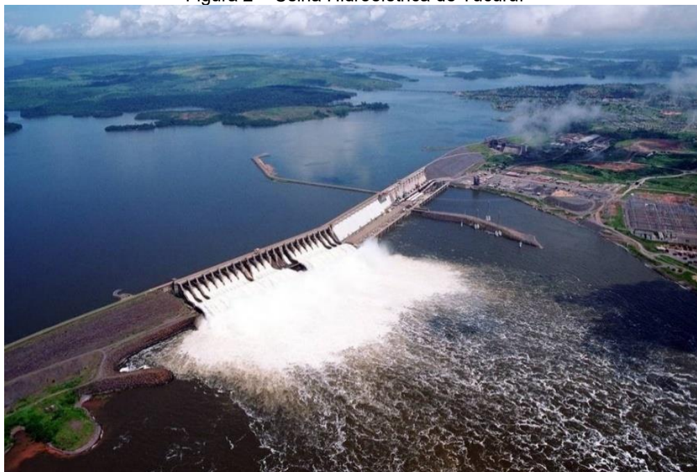
Figura 2 – Usina Hidroelétrica de Tucuruí
