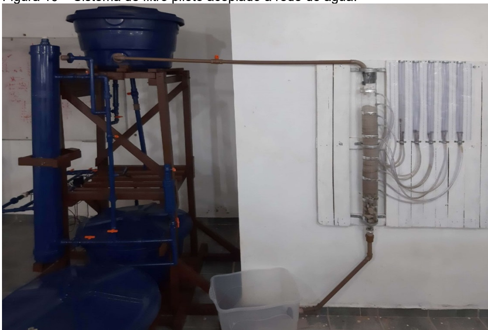
Figura 16 – Sistema de filtro piloto acoplado à rede de água.
