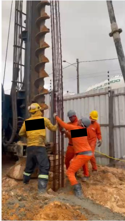
Figura 8 - Inserção da armadura da estaca.
