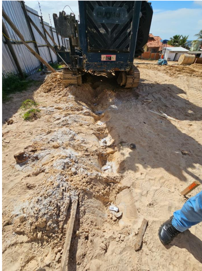
Figura 5 - Marcação do local para perfuração de estaca hélice contínua.
