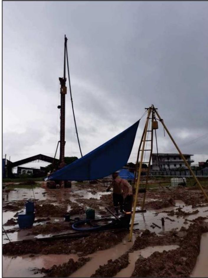
Figura 10 - Execução do furo de sondagem.
