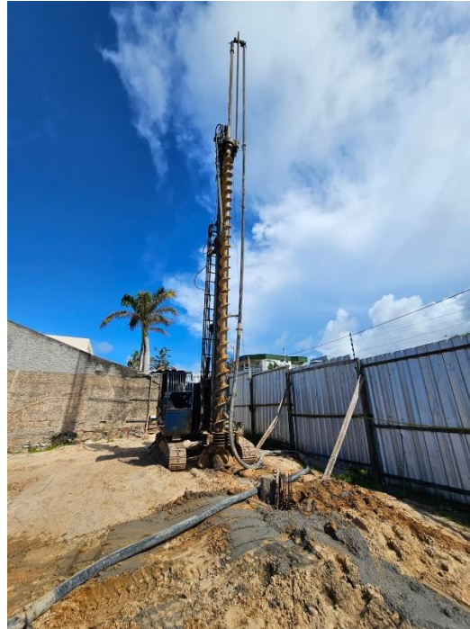
Figura 6 - Máquina de perfuração das estacas (perfuratriz).
