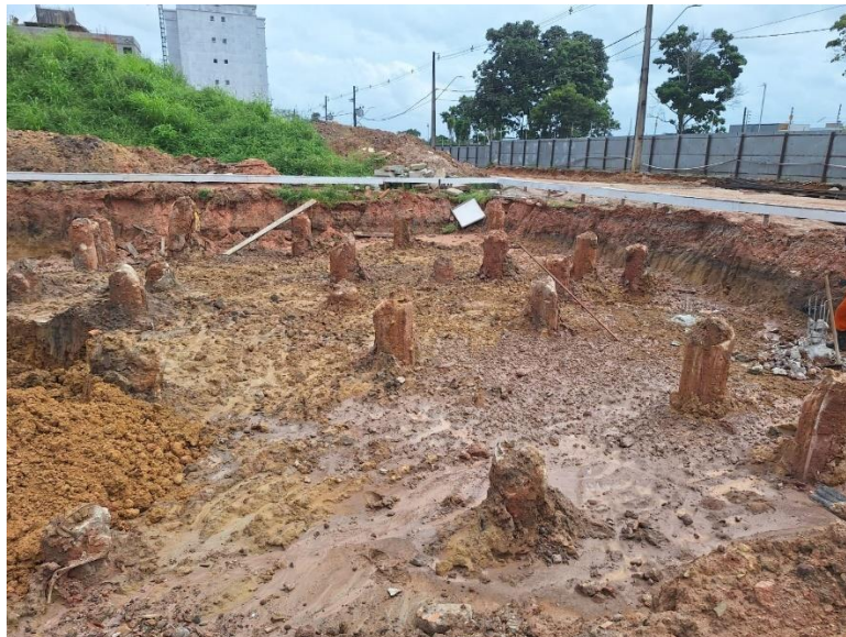
Figura 4 - Fundação em estaca hélice contínua.
