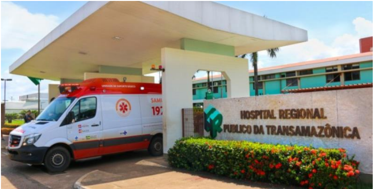
Figura 02 - Hospital Regional Público da Transamazônica
